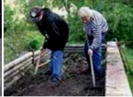
Κατασκευή πεζουλιού για το προαύλιο
